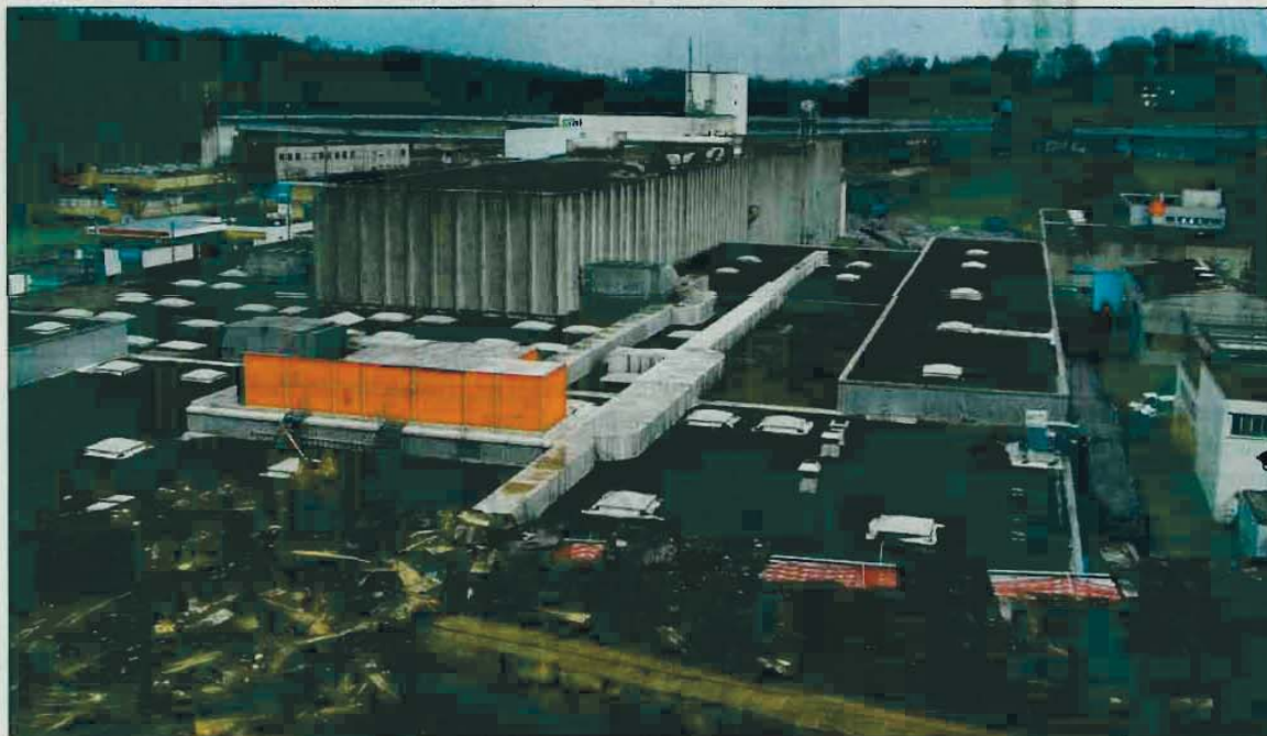
Hier in der Manegg sollen bald die Bagger auffahren.
